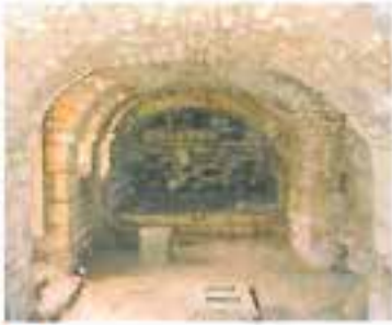
54 Kils, İslamboy Konağı
